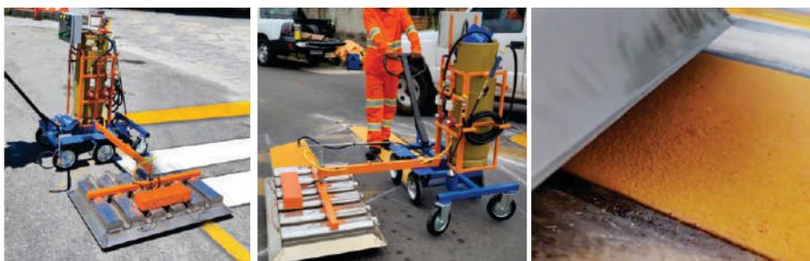
O Aplicador Termoplástico [ICDVIAS.com.br](http://ICDVIAS.com.br) representa uma solução dedicada à aplicação de marcações pré-formadas termoplásticas em pavimentos de asfalto ou concreto, otimizando a eficácia da aderência ao pavimento através do aquecimento uniforme da superfície do termoplástico, garantindo uma aplicação consistente e de alta qualidade.
